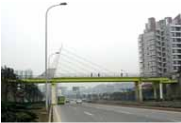
图 1 重庆 FRP 斜拉桥
