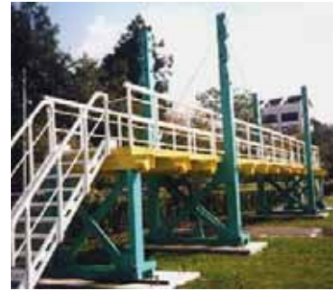
图12 日本全FRP试验桥
