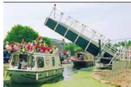
图 18 Bond Mill 桥：开合式 FRP 桥
