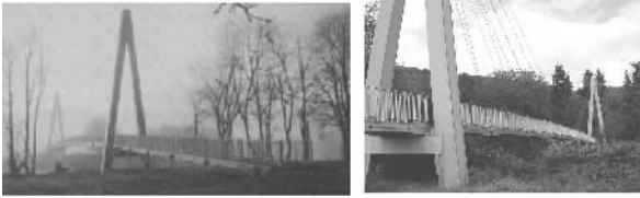
图 8 全 FRP 斜拉桥 (英国)
