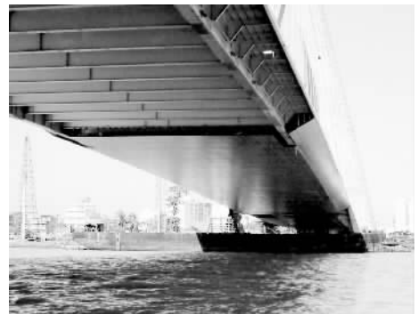
图 11 FRP 桥梁封护系统 (泰国)
